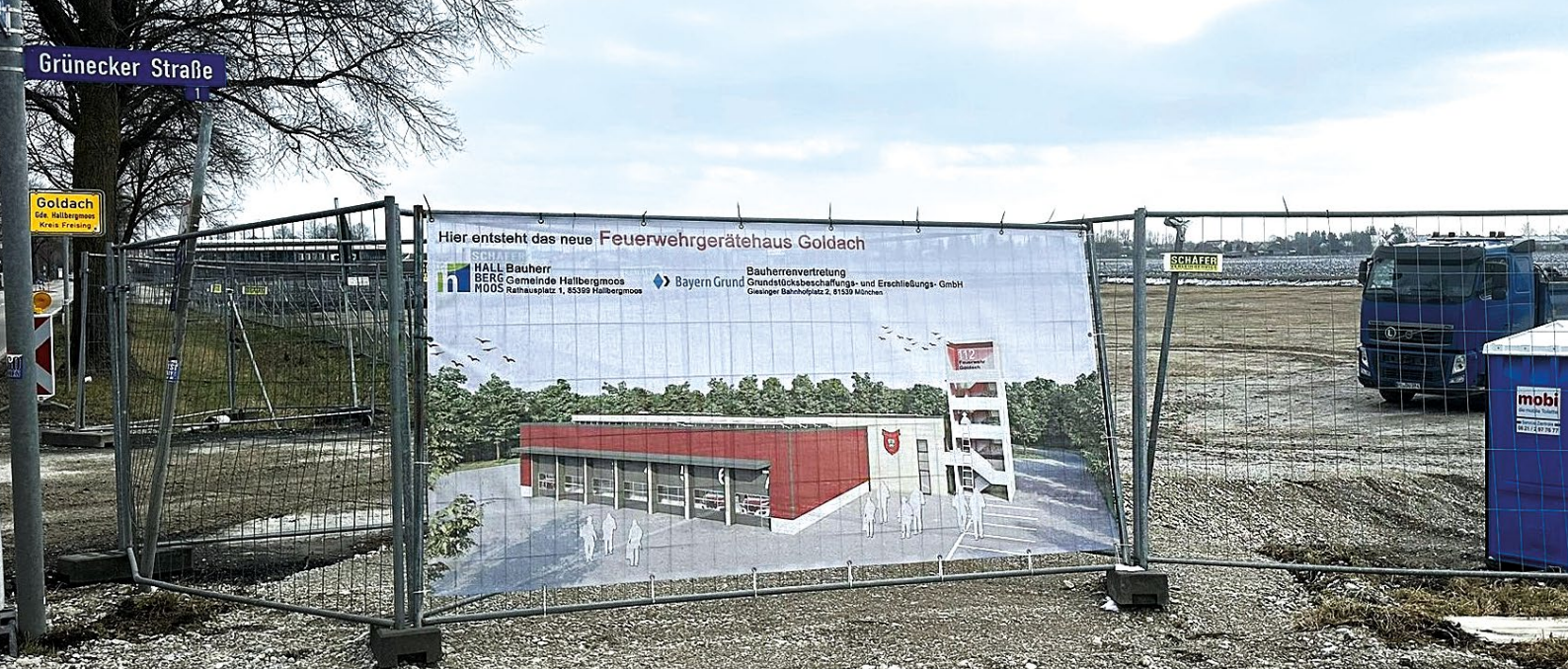
Die neue Goldacher Feuerwehr ist eines der geplanten Großprojekte
